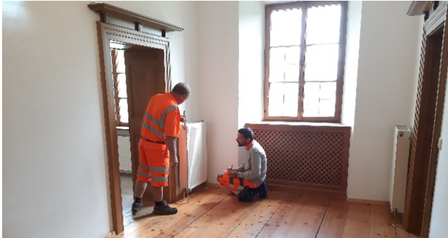
Bild: Unsere Bauhofmitarbeiter bei Adaptierungsarbeiten.
